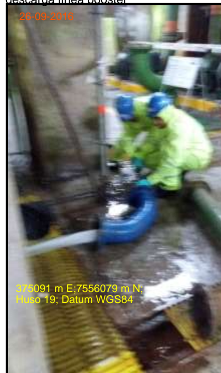
Foto 8: Limpieza con agua a presión descarga línea booster
