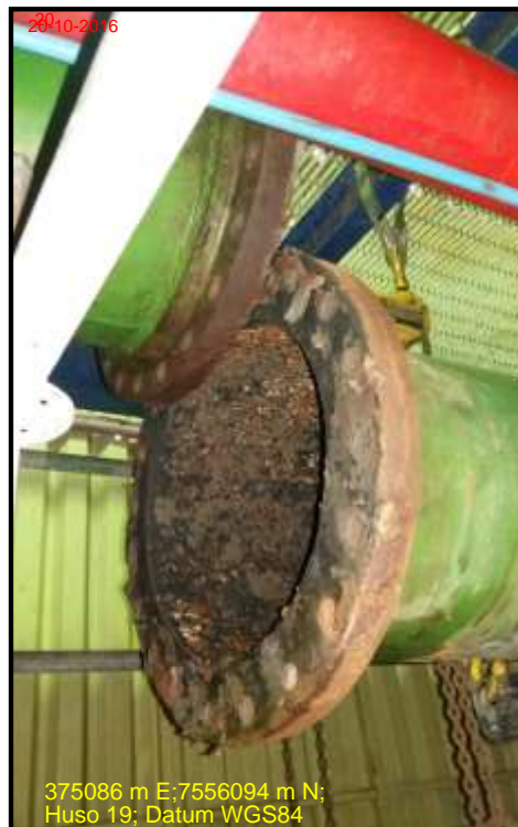
Foto 16: Ducto circulación auxiliar después de la limpieza
