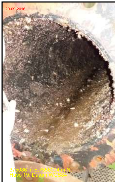
Foto 20: Ducto circ. aux. antes de limpieza
