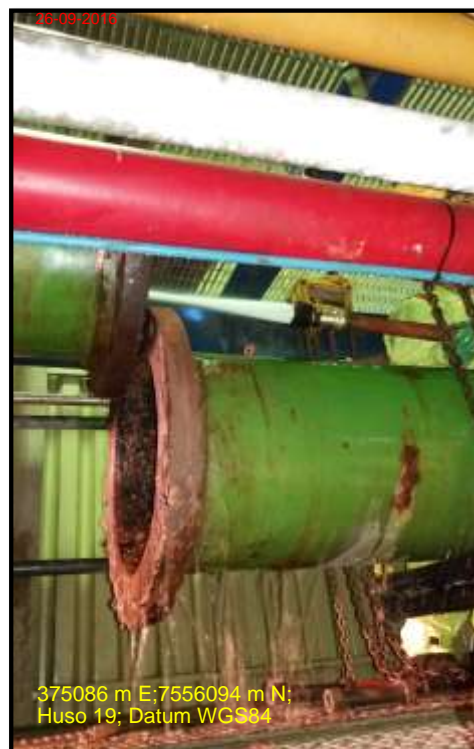
Foto 16: Ducto circulación auxiliar después de la limpieza
