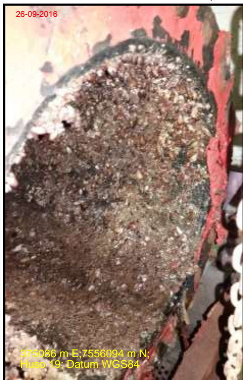
Foto 19: Ducto circ. aux. antes de limpieza
