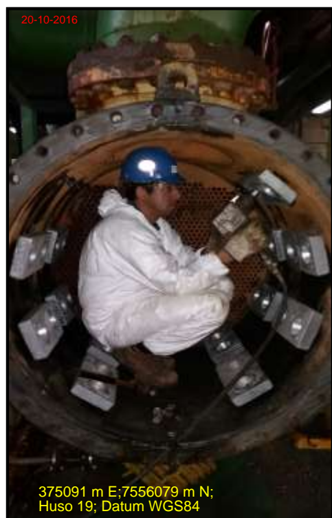
Foto 23: Cambio ánodos de Zinc enfriador auxiliar
