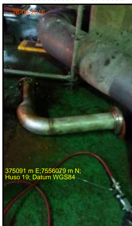
Foto 4: Codo succión línea booster
