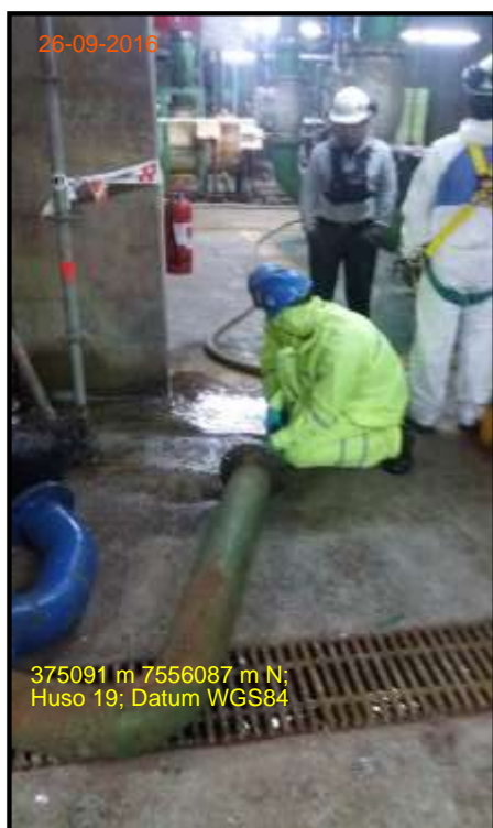
Foto 7: Limpieza con agua a presión
