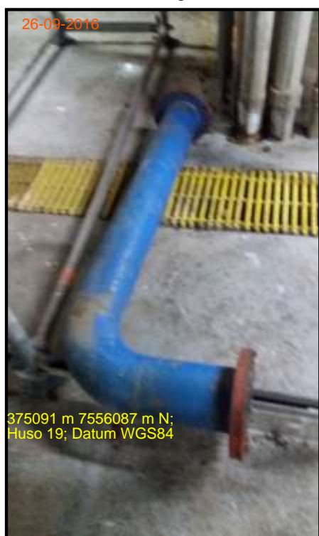
Foto 3: Codo descarga línea booster
