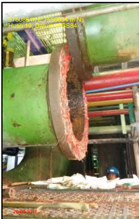
Foto 19: Ducto circ. aux. antes de limpieza
