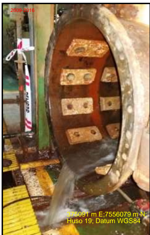
Foto 23: Cambio ánodos de Zinc enfriador auxiliar
