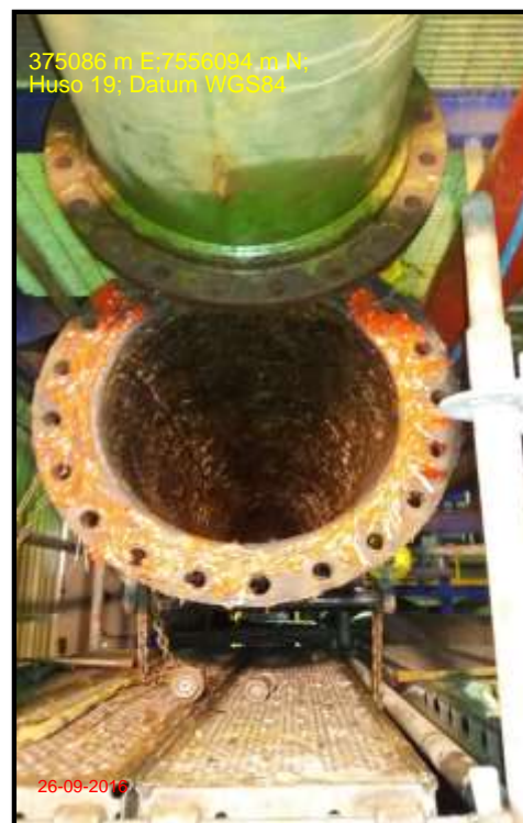
Foto 20: Ducto circ. aux. antes de limpieza
